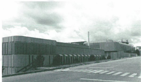
Los Alamos Facility
